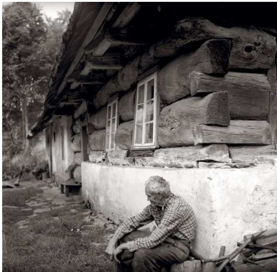
Charakteristické roubení na Těšínsku z podélně půlených jedlových trámů. Řeka č. 7, okres Frýdek-Místek, 1973. (Foto František Papež)
