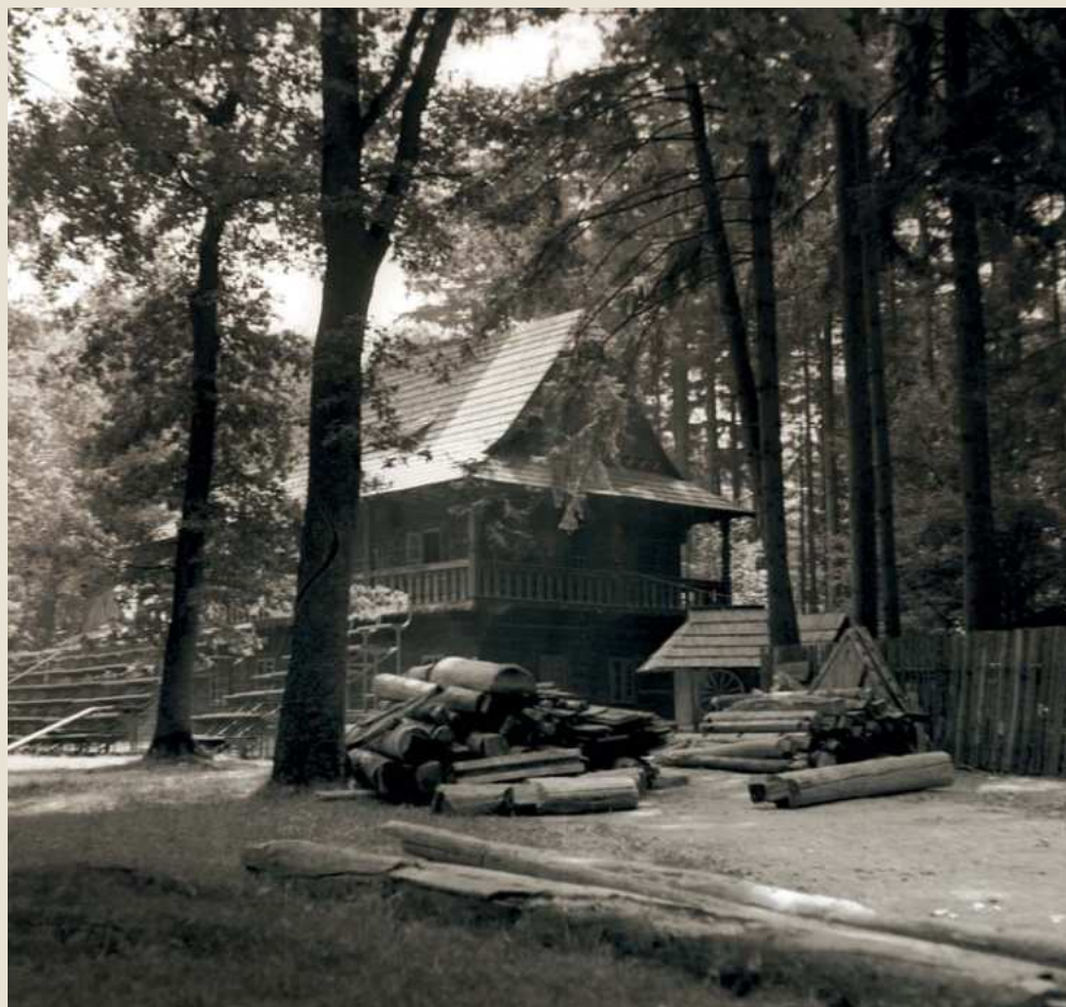
Uložení prvků z demontovaných staveb u fojtství z Velkých Karlovic v Dřevěném městečku. Valašské muzeum v přírodě, 1963. (Foto Vanda Bulawová)
