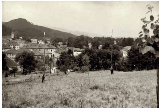
Situování objektů na Valašské dědině, rozměry jsou vykolíkovány a vymezeny tyčí s výškou hřebene stavby. Stavebnětechnická dokumentace Valašského muzea, počátek 70. let 20. století.
